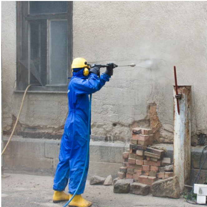
Sanierung einer Fassade Restoration of a facade Assainissement de façade
