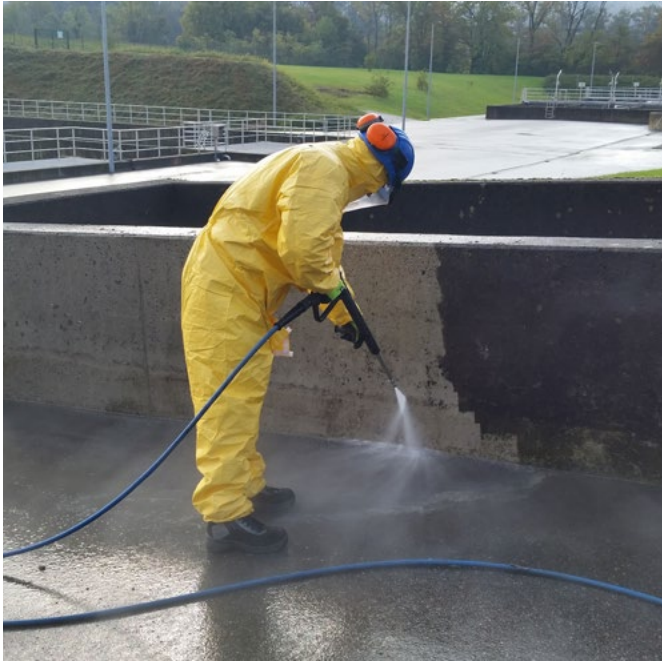
Sanierung einer Kläranlage Renovating a wastewater treatment plant Rénovation d'une station d'épuration
