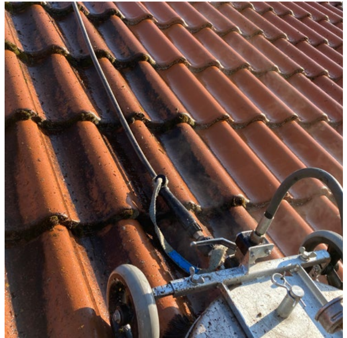
Reinigung von Dächern Roof cleaning Nettoyage des toitures
